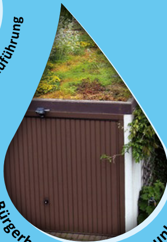
Zustands- und Funktionsprüfung
