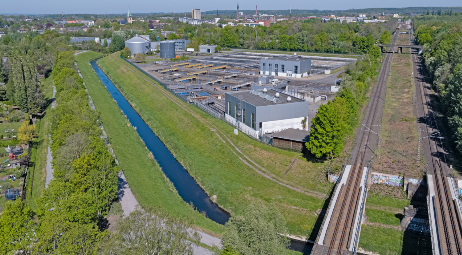
Luftbild Kläranlage Sesekemündung
